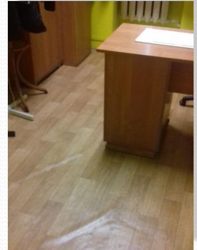
PP w Łaskarzewie — wymiana wykładziny, malowanie pokoi biurowych
