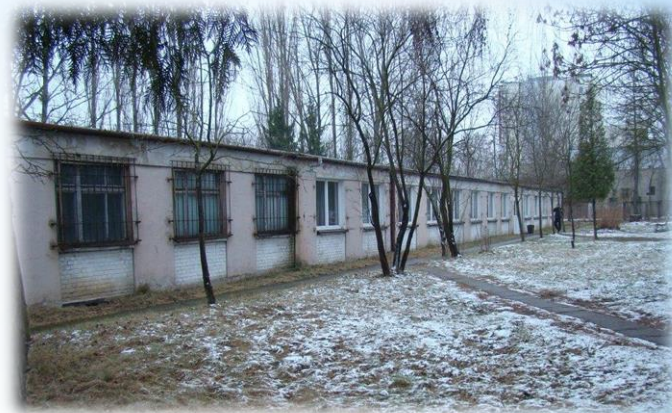
SPPP w Płocku – termomodernizacja budynku wraz z modernizacją systemu grzewczego.
