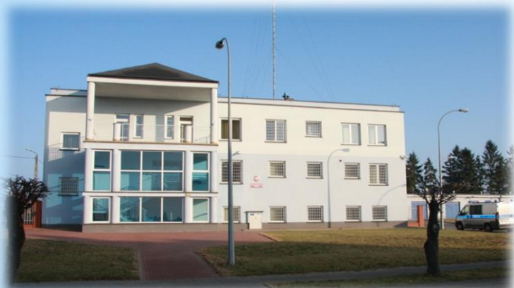
KPP Łosice – przebudowa wraz z termomodernizacją.
